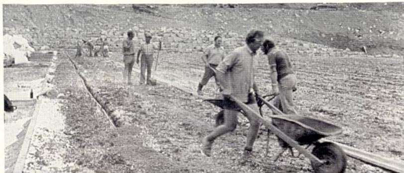
Im Zuge dieser Arbeiten setzten auch die Eigenleistungen der TuS-Mitglieder ein; ca. 7000 lfd. m Drainagerohre mußten verlegt und die Gräben mit Kies aufgefüllt werden.
